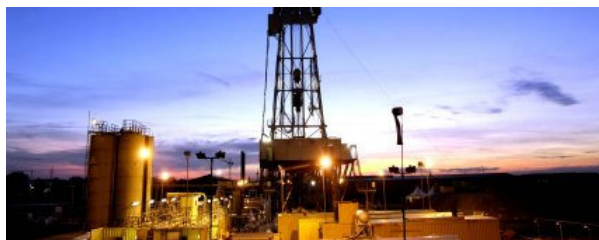
Geothermieanlage in Sauerlach bei München
